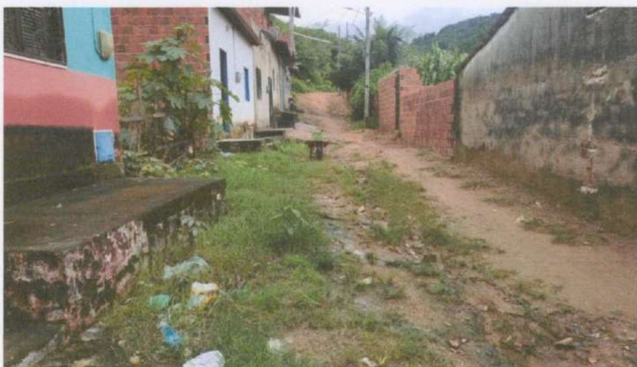
Foto 02 – Beco do Mel no Lajeiros 24M | 443156.41 m E | 9599494.16 m S
